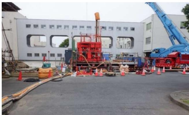
高圧噴射攪拌工法による地盤改良
