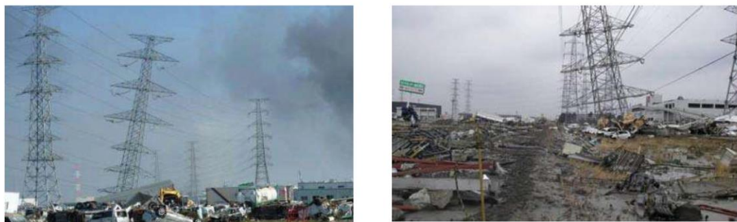
図 1.5.3-2 台風や津波による鉄塔倒壊事例
