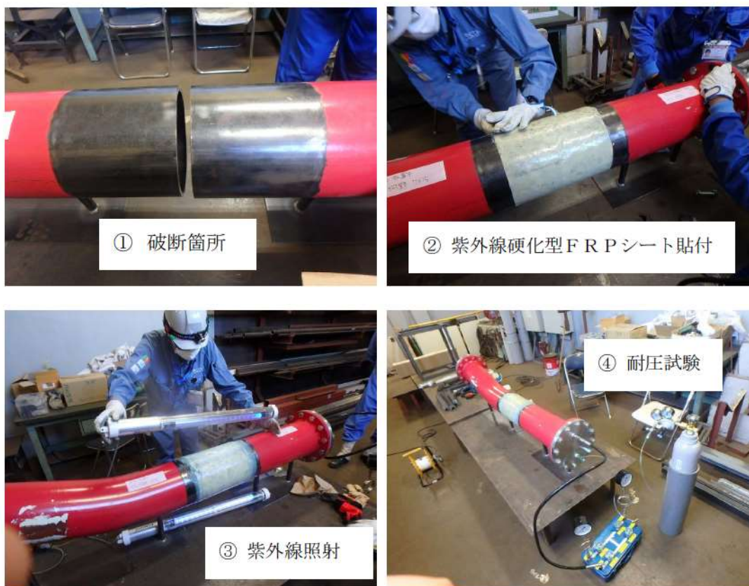
第10図 紫外線硬化型FRPシートによる修復作業概要（モックアップ）
