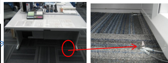
運転指令卓横の パトローラ機の固定状況
