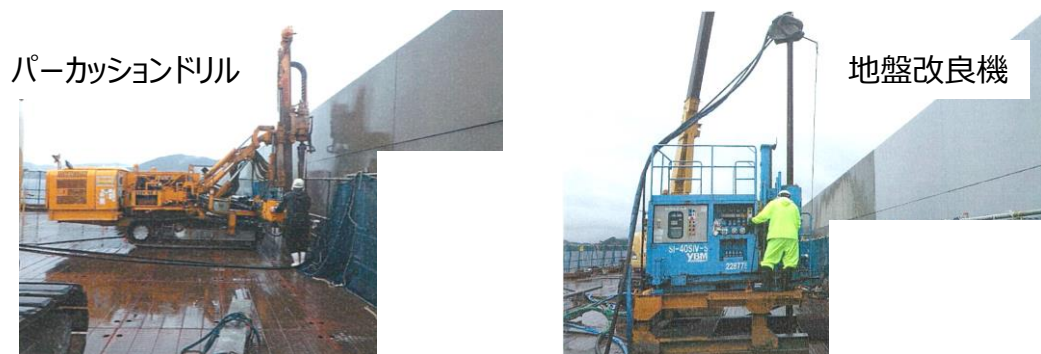
図2-5 ケーソン中詰材改良の施工状況
