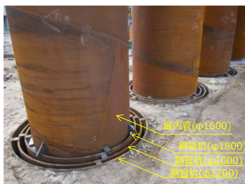
多重鋼管杭建込み状況 （モルタル（充填材）打設前）
