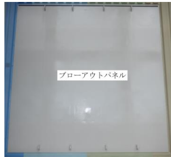
パネル据付状況 (全景)
