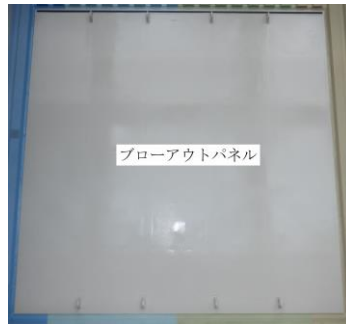
パネル据付状況 (全景)
