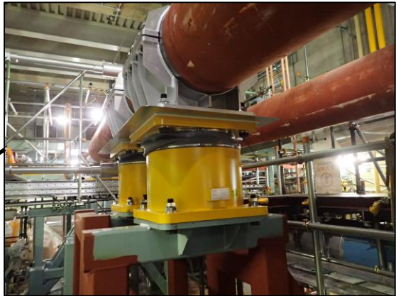
三軸粘性ダンパの設置例
