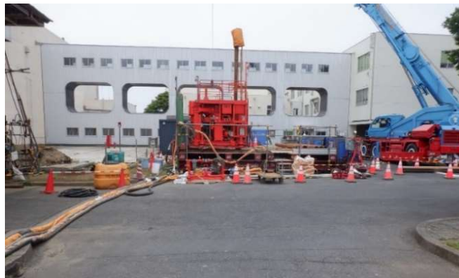
高圧噴射攪拌工法による地盤改良 (「常陽」敷地における試験施工の状況)
