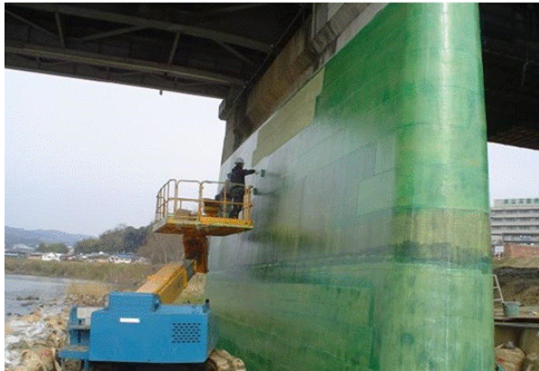
(a) 橋脚補強
