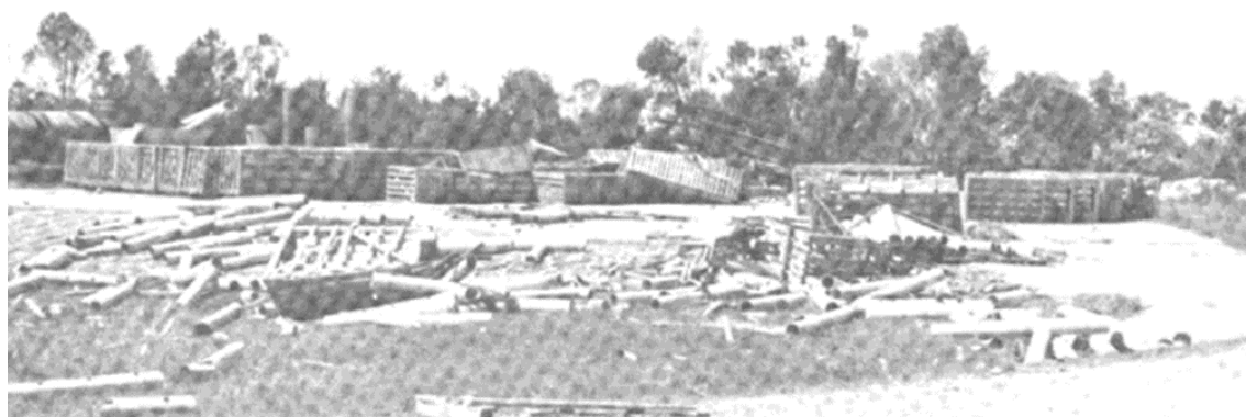
第 2.1 図 米国 Grand Gulf 原子力発電所における竜巻による資材置き場パイプの飛散状況
