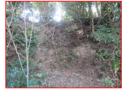
調査露頭写真（写真B） 露頭下部(露頭③)
