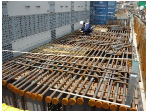
フーチング組立状況
