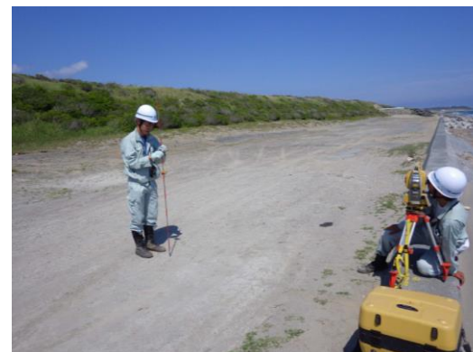
海岸線地形測量実施状況 (陸上部)
