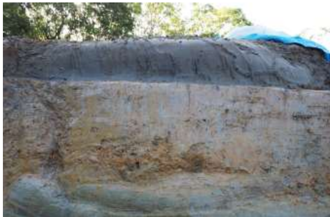
「泥層」露頭（北トレンチ東面）
