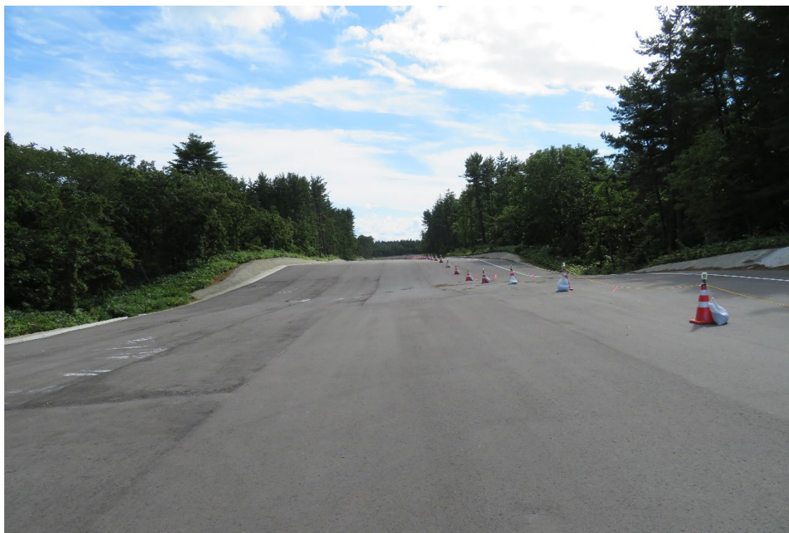
第 3-6 図 防火帯の施工状況の例
