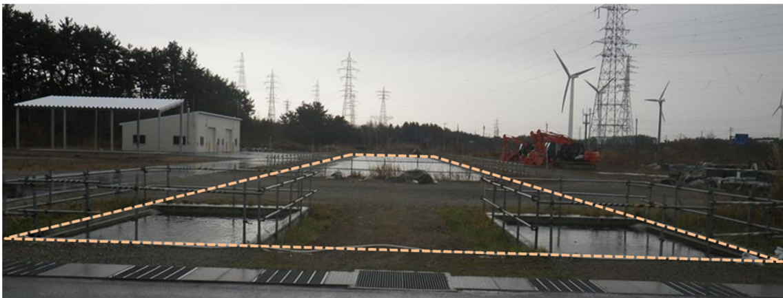
22. 旧バッチャープラント・貯水地
