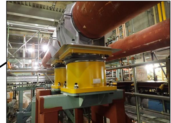
三軸粘性ダンパの設置例
