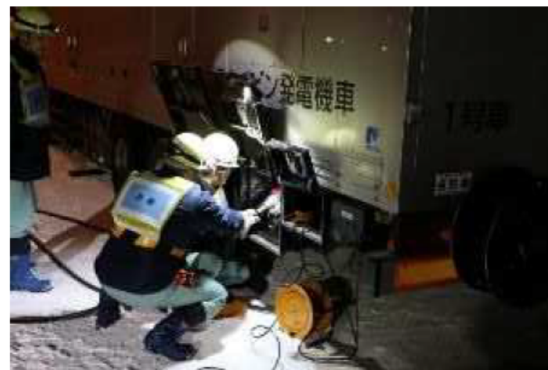
電源車へのケーブルの繋ぎこみ
