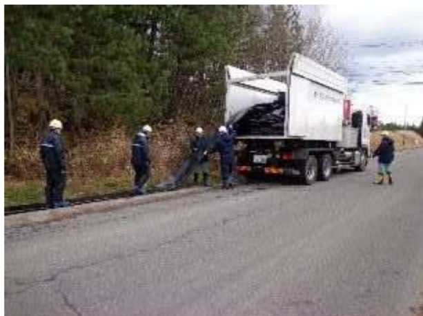
建屋外ホースの敷設
