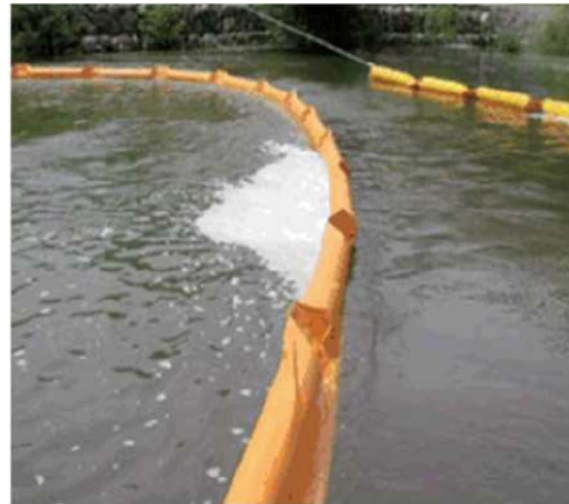
可搬型汚濁水拡散防止フェンス
