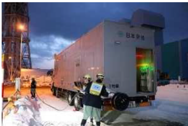
電源車から建屋にケーブルを敷設
