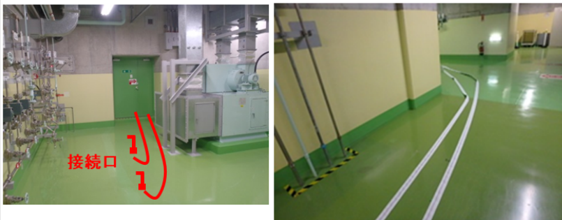
第 2. -28 図 精製建屋の精製建屋のセルへの導出経路の構築及び代替セル排気系による対応概要 (その 1)
