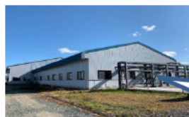
タンク周りの風速及び温度の測定状況 （第2一般排水処理建屋）
