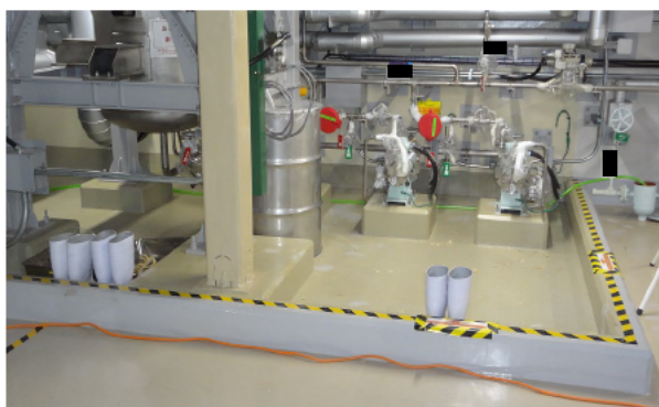
第1図 法令に基づき設置している堰
