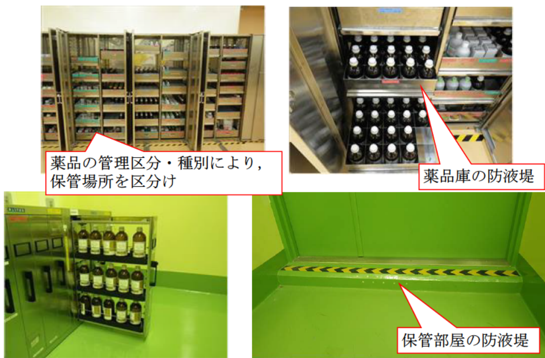
第3.2図 分析用試薬の保管状況
