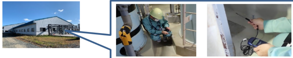
タンク周りの風速及び温度の測定状況 （第2一般排水処理建屋）
