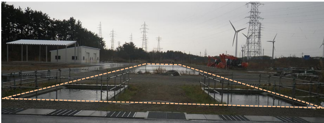
22. 旧バッチャープラント・貯水地
