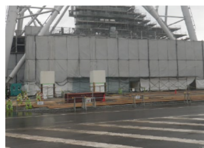
③試薬建屋入口から北側を撮影
