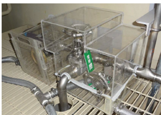
第2図 漏えい化学薬品の飛散防止用の飛散防止カバー等
