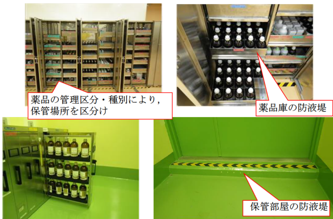
第3.2図 分析用試薬の保管状況
