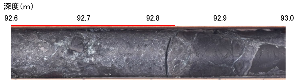
コア写真 = 破碎部
