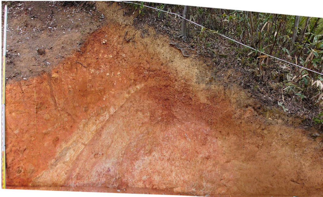
大坪川左岸 表土はぎ写真
