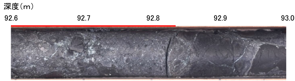
コア写真 = 破碎部
