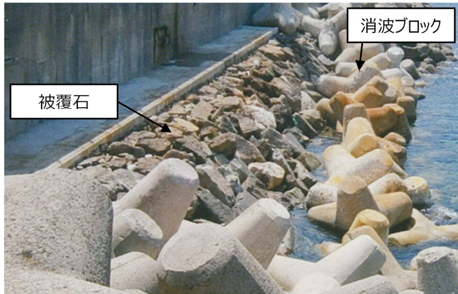
被覆石の設置状況（1，2号機北側護岸）
