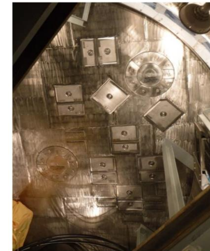
図 1-3 コリウムシールド外観
