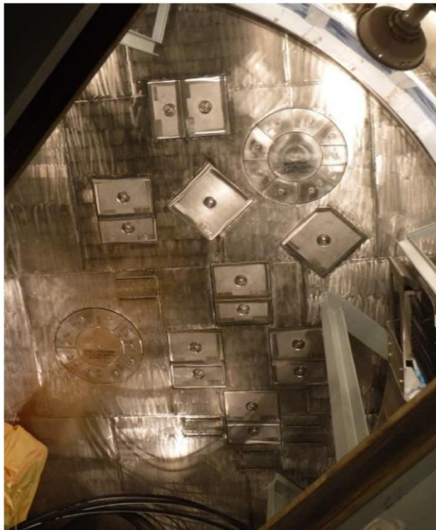
図 1-3 コリウムシールド外観
