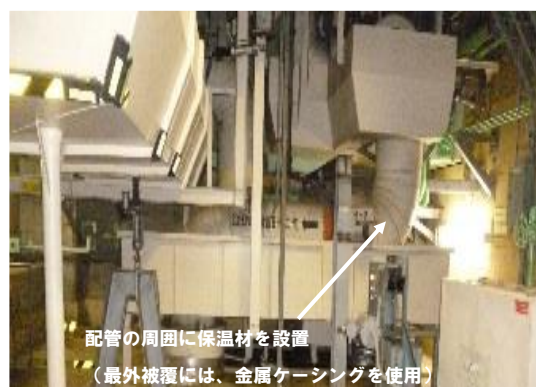
(2次主冷却系の配管)
