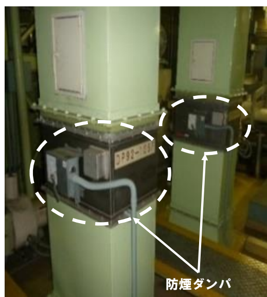
第1図 防煙ダンパ等の設置状況
