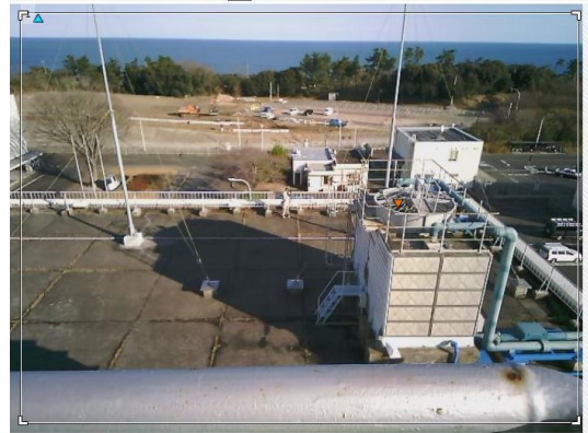
主冷却機建物屋上（非常用ディーゼル冷却塔）
