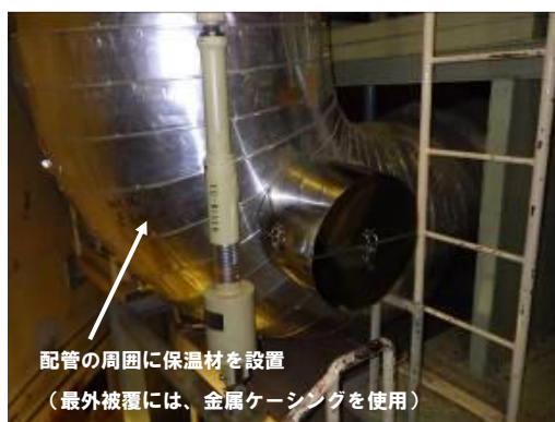
(1次主冷却系の配管)
