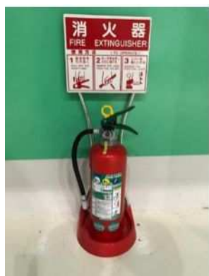
・ 消火器具 (左から, 粉末 (ABC) 消火器・大型粉末消火器)
