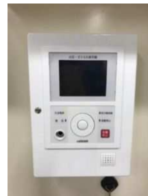
・ 自動火災報知設備 (左から, 差動式スポット型感知器・光電式スポット型感知器・光電式分離型感知器・火災受信機・表示機)
