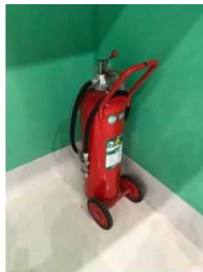
・ 消火器具 (左から, 粉末 (ABC) 消火器・大型粉末消火器)
