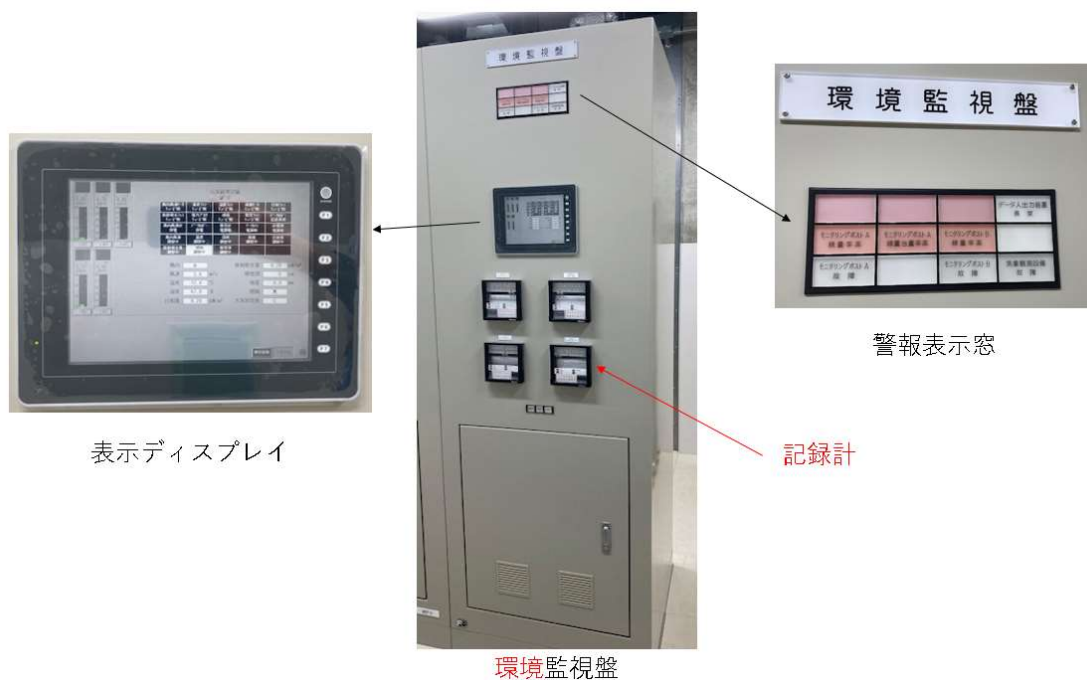
第8-1図 環境監視盤の警報表示窓と表示ディスプレイ
