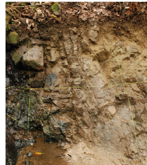
写真② 安山岩(均質)に発達する板状割れ目 (上:割れ目を加筆, 下:加筆なし)
