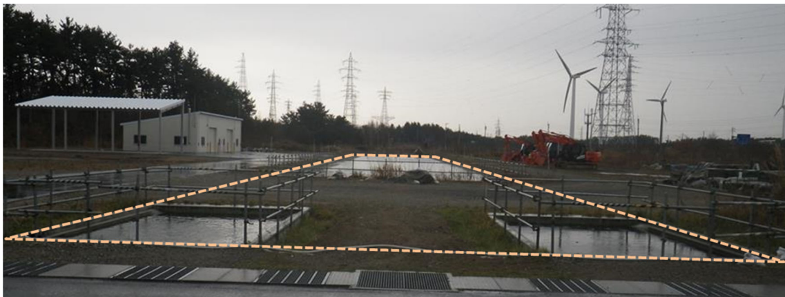
22. 旧バッチャープラント・貯水地
