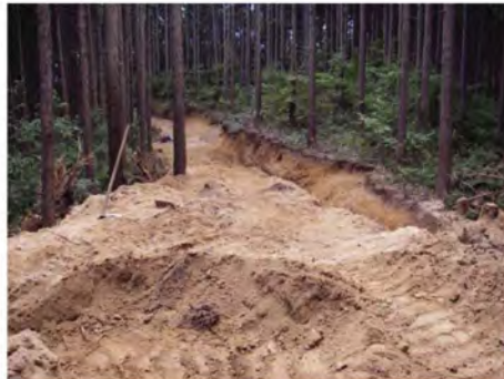
写真2 トレンチ全景(北東端から撮影)
