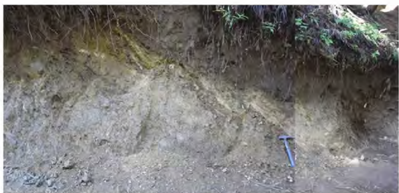
断層部の全景
