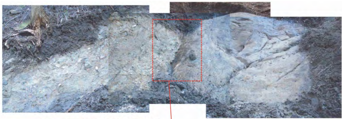
写真1 道清右岸側斜面露頭 (スケッチ箇所)
