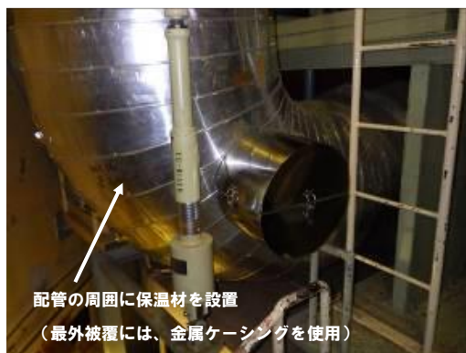
( 1 次主冷却系の配管 )
