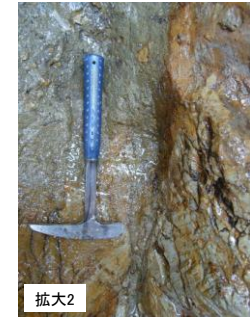
● 砂岩と泥岩の境界の断層面の連続性はやや不明瞭でしばしば分岐し、平面性は低い。また幅約5mmの砂礫岩を挟在しているが、粘土状破碎部を伴わない。 ● 砂礫岩は、周囲の砂岩層と同様の固結の程度である。
