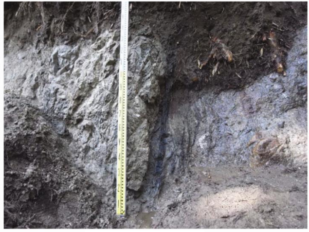
写真① 断層部の全景
