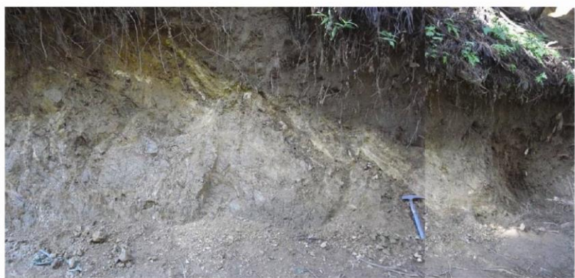
断層部の全景
