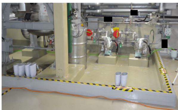
第1図 法令に基づき設置している堰
