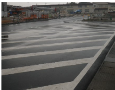
① 試薬建屋入口から 東側を撮影
