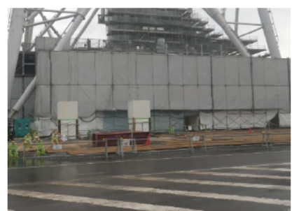
③ 試薬建屋入口から 北側を撮影
