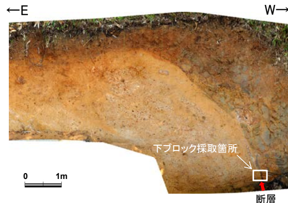
試料採取箇所 (大坪川ダム右岸北道路)
