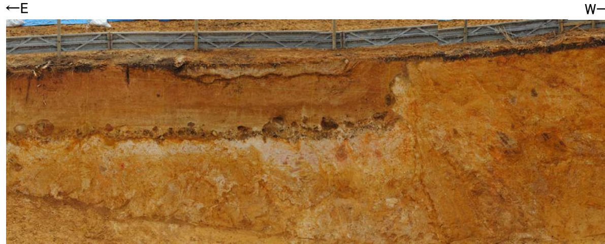
南壁面写真(断層付近)
