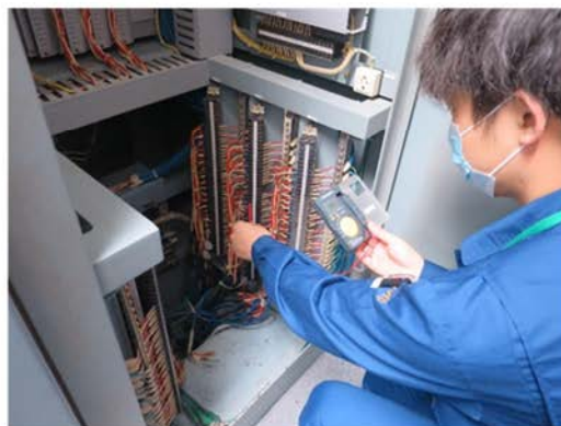
仮設計器による温度確認の一例
