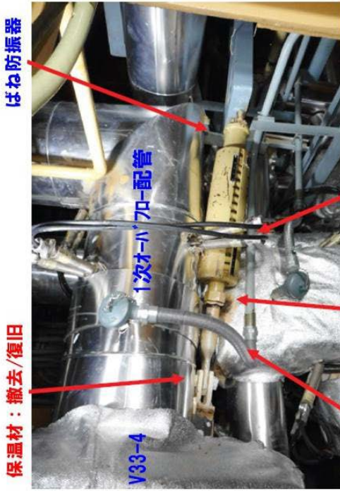
ばね防振器からメカニカル防振器への交換の例②
