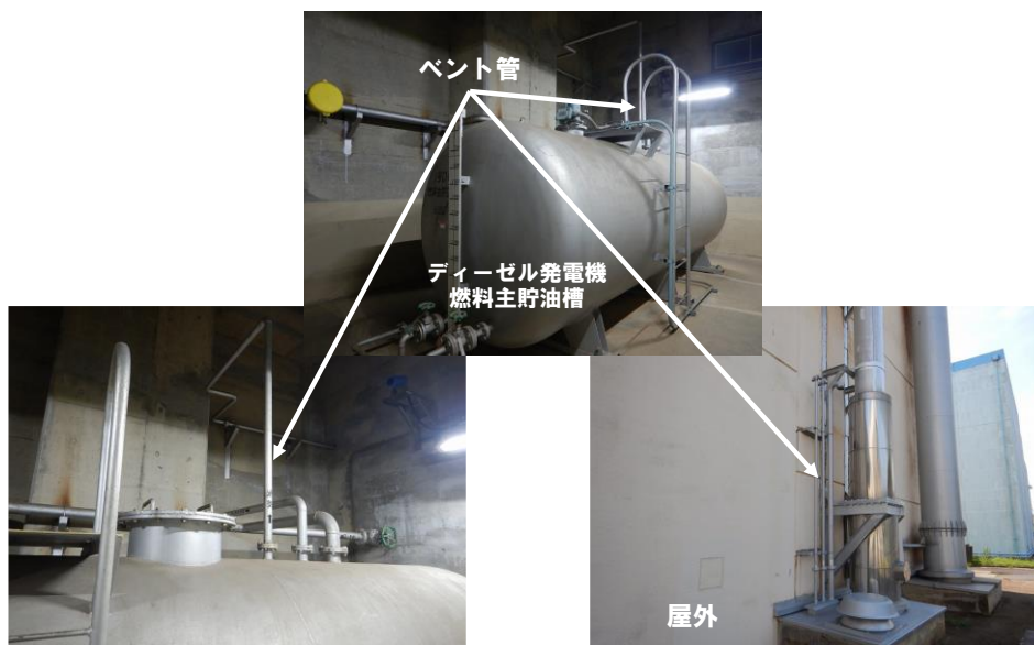
第 6.1 図 燃料油を貯蔵するタンクのベント管の設置例（ディーゼル発電機燃料主貯油槽）
