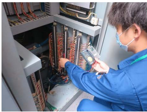
仮設計器による温度確認の一例
