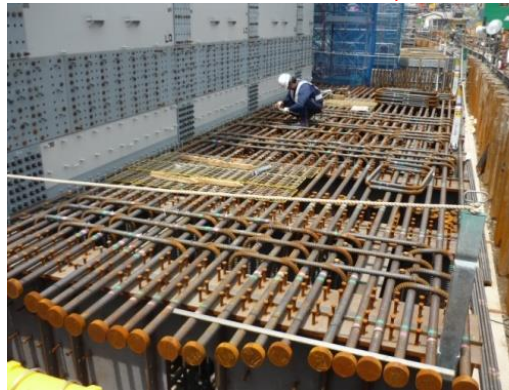
フーチング組立状況
