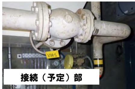
\*1：タンクローリ、可搬式気化器及びフレキシブルホースにより、アルゴンガスを供給（接続部は、新設）
