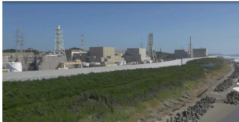
防波壁前面の砂丘堤防（海側から撮影）
