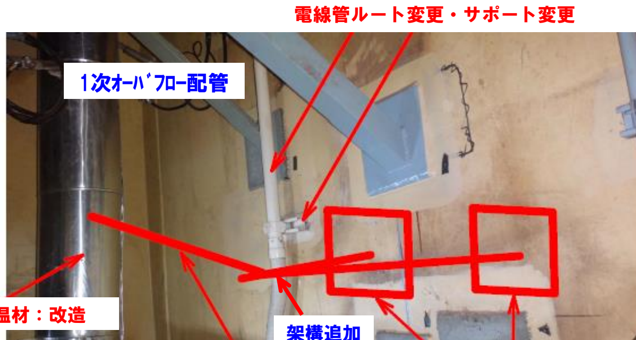
メカニカル防振器追加 パット追加 メカニカル防振器の追加の例①
